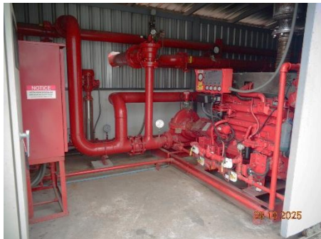
ภาพที่ 2.1-25 ระบบปั้มน้ำดับเพลิงและถังเก็บโฟมดับเพลิง
