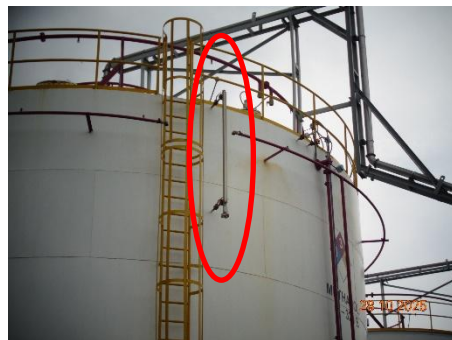
ภาพที่ 2.1-35 Temperature and Level Detector และ Temperature and Level Alarm
