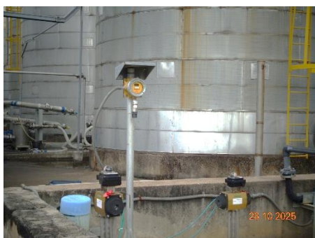
ภาพที่ 2.1-30 ระบบตรวจจับการรั่วไหลของฟอร์มัลดีไฮด์ (Fixed Gas Detector)
