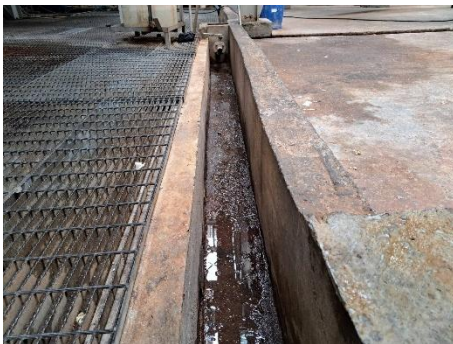
ภาพที่ 2.1-7 รางระบายน้ำเดิมของโครงการ บริเวณพื้นที่รื้อถอน
